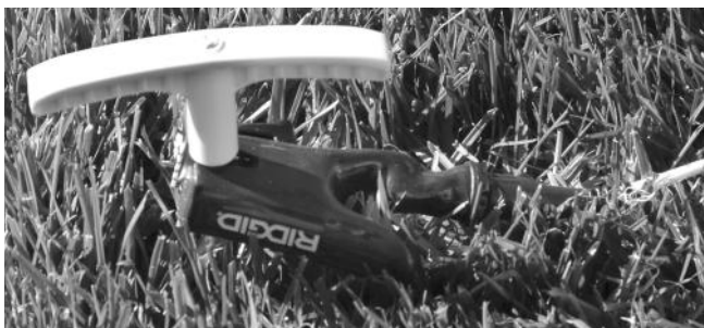
Рис. 7 – присоединение провода к заземляющему штырю
